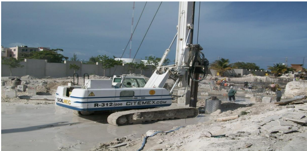
Cimentaciones Profundas de Occidente, S. A. de C. V.
